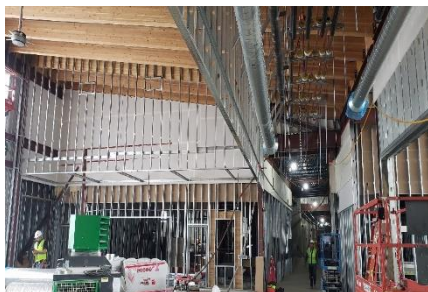
COMMONS SOFFIT FRAMING
