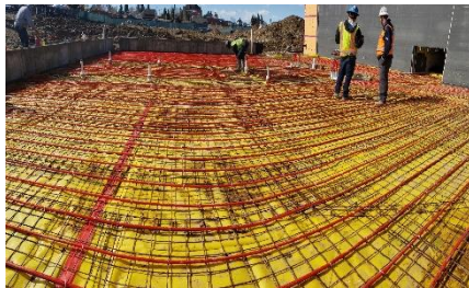
SLAB POUR FOR ADDITION
