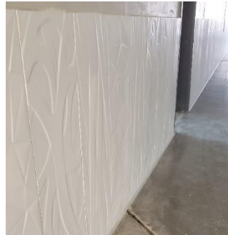
WALL TILE @ECE CORRIDOR
